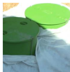
Amikor a tartályokat a terepszinttől 20 - 30 cm-re temették el, fektesse le a geotextíliát
