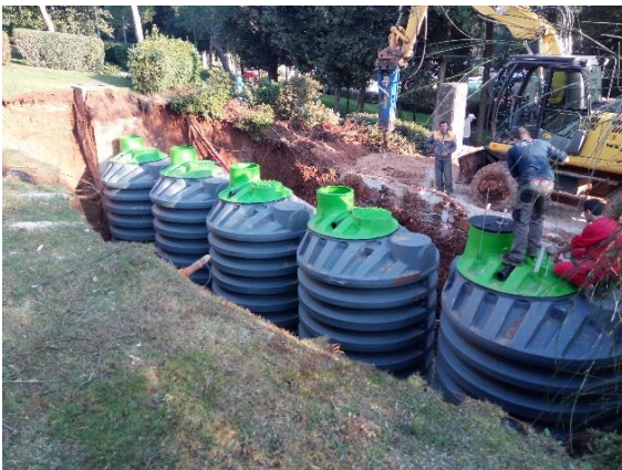
5.sz. kép: Tartályok sorba telepítése
