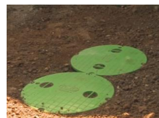
Végezetül a gödör utolsó 20 - 30 cm-re réteget földdel töltse fel
