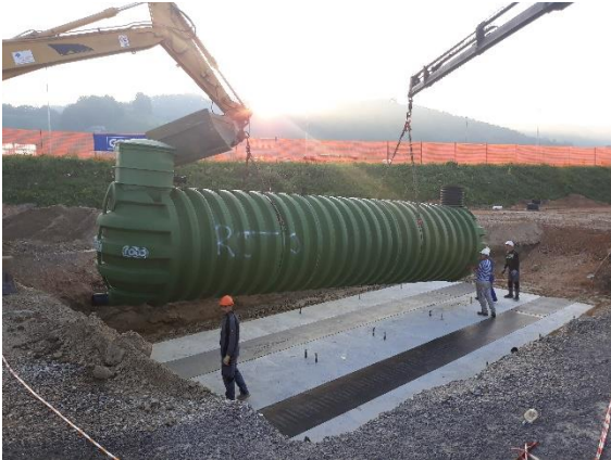
4. sz. kép: A tartály telepítése
