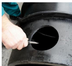
A lyuk kerületének kitisztítása
