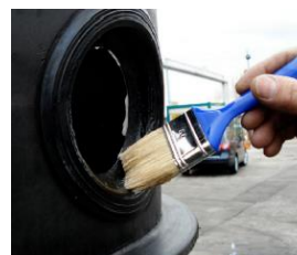
A gumitömítés behelyezése
