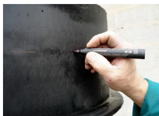
Kijelöljük a Befolyó cső helyét (PE csőnek egyenes területe van a befolyó cső részére)
