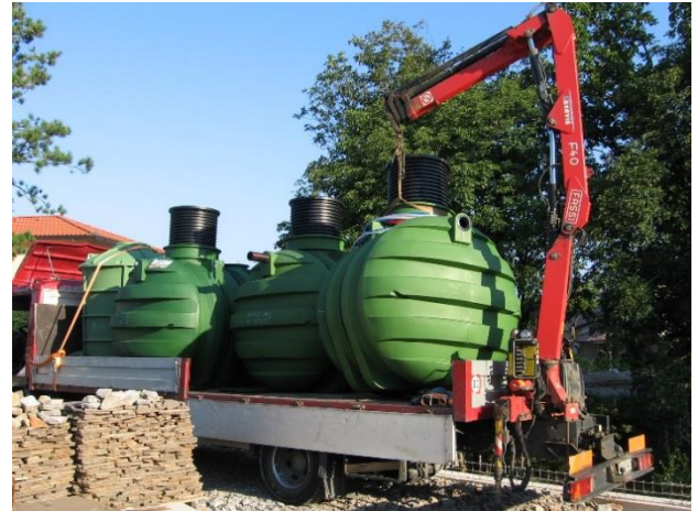
1. sz. Kép: Megfelelő szállítás és lepakolás
