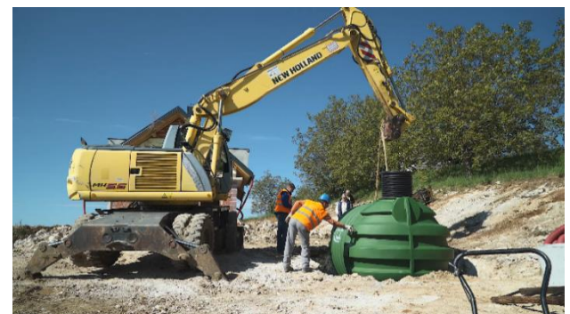
3. sz. Kép: A tartály telepítése
